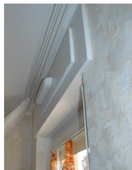
Façade d'un coffre menuisé réhabilité avec de la laine de roche (doc. ESPACE9)
