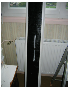
Face intérieure d'un coffre PVC isolé avec une masse lourde bitumineuse (doc. ESPACE9)
