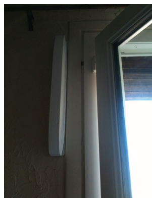
Vue de l'intérieur du logement
