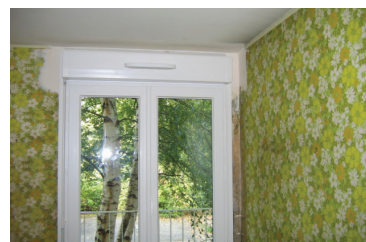
Bloc baie après finition (doc. ESPACE9)
