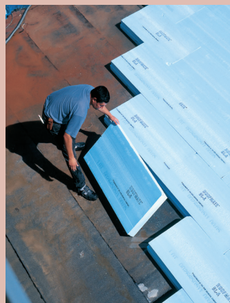
Polystyrène extrudé, PSX (doc. DOW)
