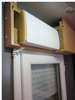
Surcoffre recouvrant l'ancien coffre PVC (doc. COFERMING)
