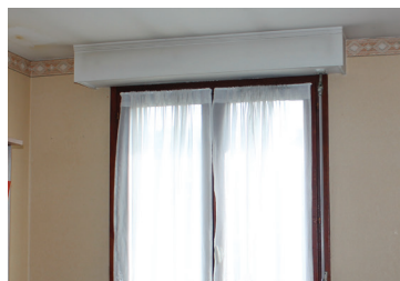
Coffres de volets roulants traditionnels (doc. ESPACE9)
