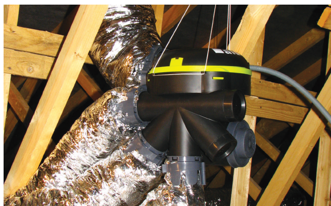
DTU : suspension du groupe d'extraction sans contact (doc. ALDES)
