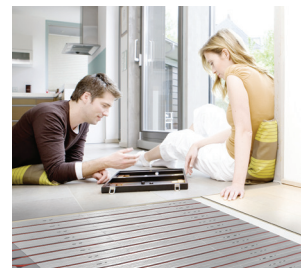
Plancher chauffant (doc. REHAU)
