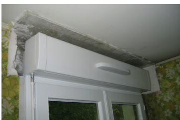
Bloc baie avant finition (doc. ESPACE9)
